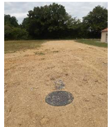
Extension du réseau d'assainissement de FOURS
