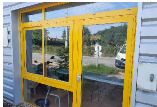
Remplacement de la baie vitrée du Centre Social de Fours
