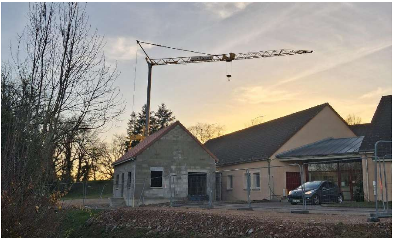
Les travaux à Maison de santé de Moulins-Engilbert
