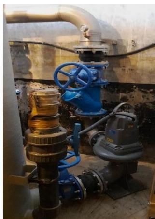
Ce poste de relevage fonctionnait avec un surpresseur qui, au bout de ses 60 ans d'existence, était hors service. La société Hydrelec a installé deux pompes au fond de ce poste de relevage.
